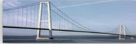
Hava Üfleli – Air Blown Fiber Uygulamaları
